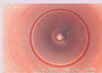
Obr. 8 Otevřený spoj 1
