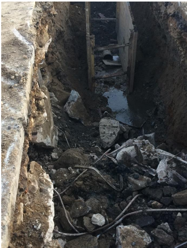
Obr. potrubí mezi šachtou ŠA-11 A ŠA-12
