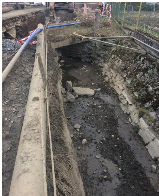
Obr. původní propustek
