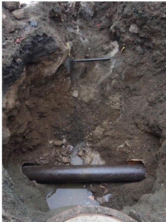
Obr. způsob oprav poškozené dešťové kanalizace před domem č.p. 112 vedle šachty ŠB 2 – 6
