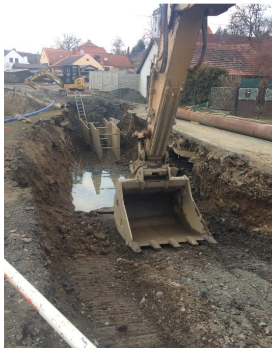
Obr. odstraňování propustku
