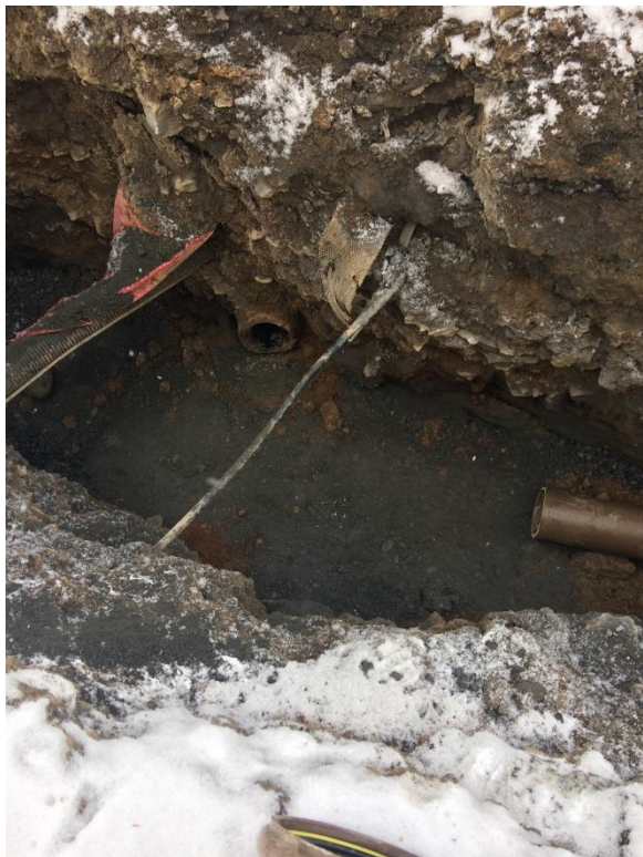
Obr. přerušení kanalizace (přípojka kanalizace u č.p. 38)
