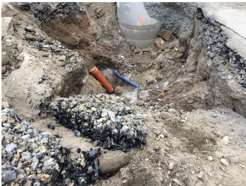
Obr. zásyp výkopu před č.p. 105 s asfaltovými krami
