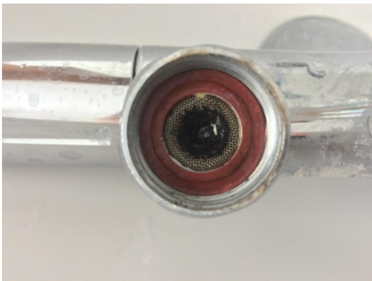
Obr. ucpaná vodovodní baterie v rodinném domě občana
