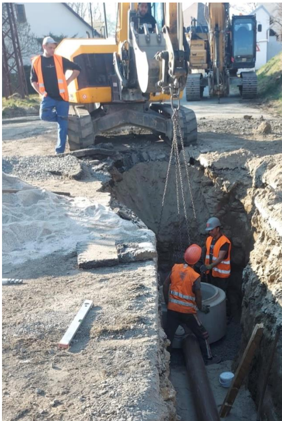
Obr. zaměstnanci společnosti JARISTAV, s.r.o., kteří mají na sobě vesty společnosti Vodohospodářské stavby, společnost s ručením omezeným
