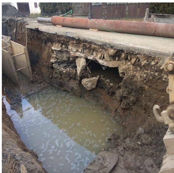
Obr. místo po odstranění propustku
