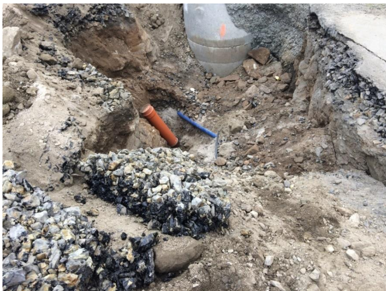
Obr. asfaltová kra vhozená zpět do výkopu
