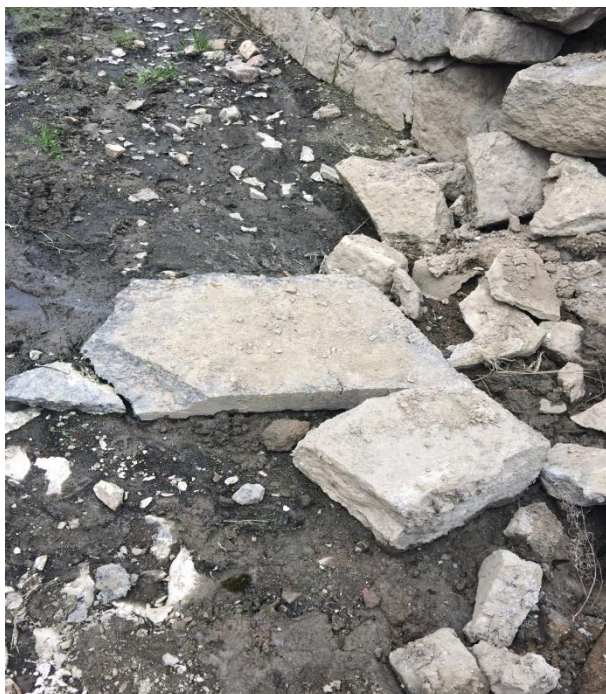
Obr. asfaltová kra v potoce koryta
