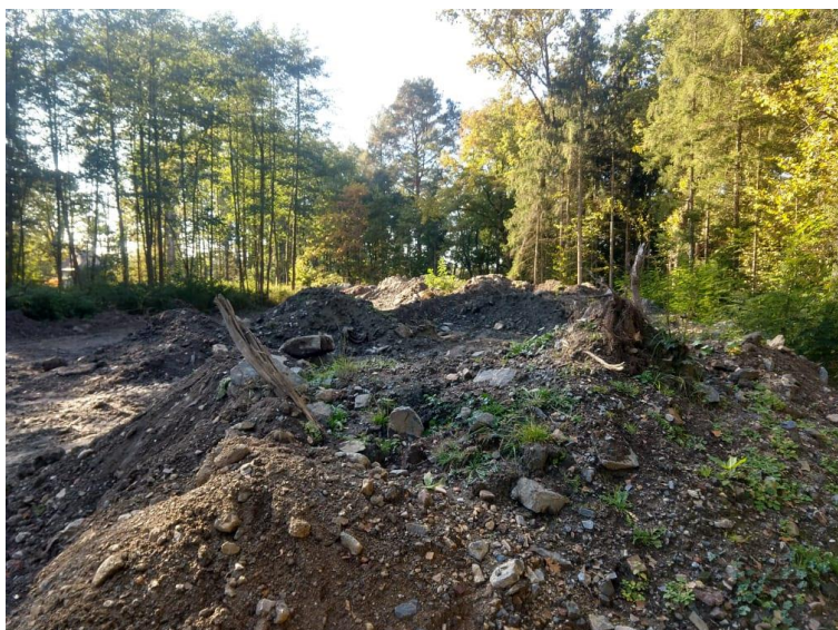
Obr. celkový pohled na skládku a okolní les
