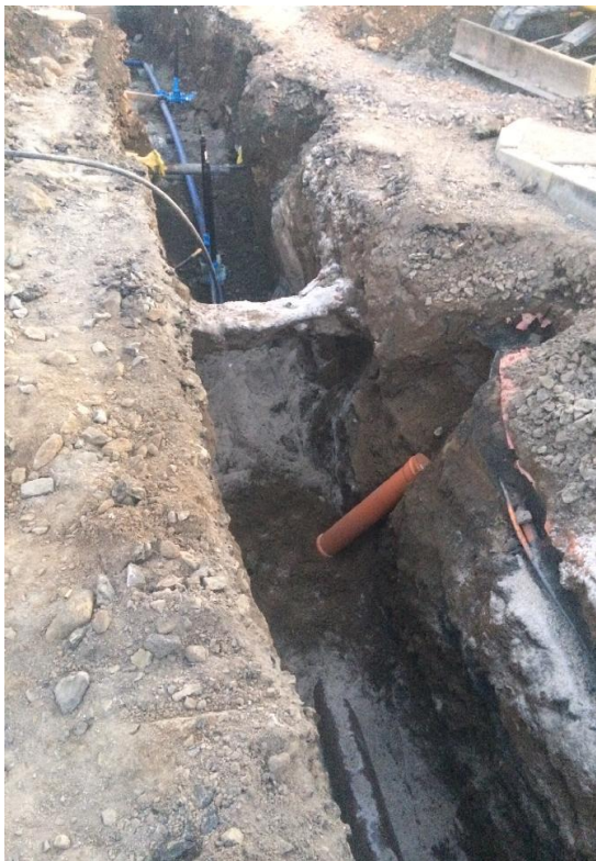
Obr. ukončení vodovodu v jižní části
