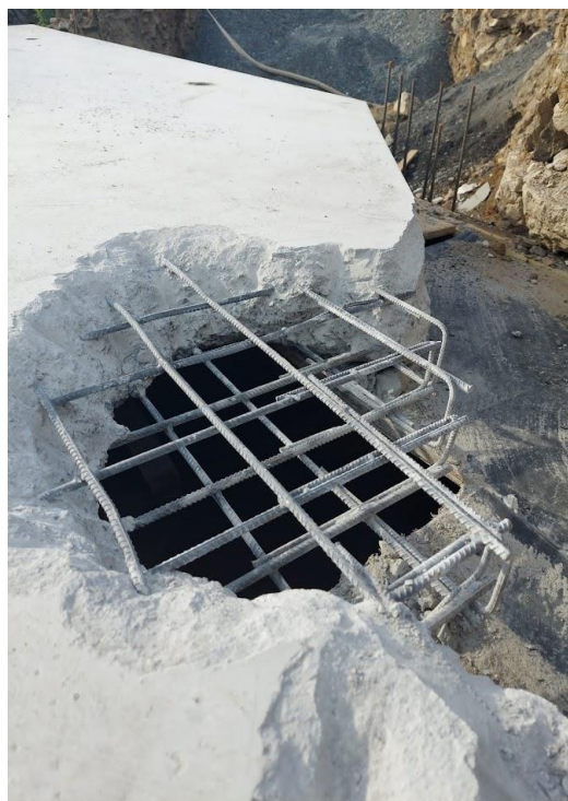
Obr. následné poškození prefabrikátu Obr. nastavování nesprávného rozměru
