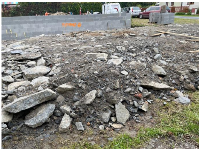
Obr. odpad ze stavby kanalizace v Makově
