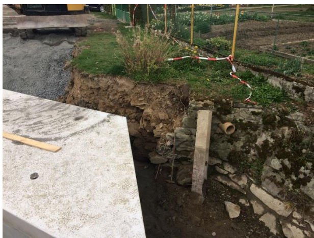
Obr. nový propustek
