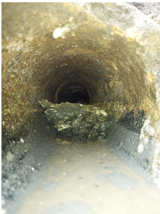
Obr. další fotodokumentace ucpané dešťové části vodovodu
