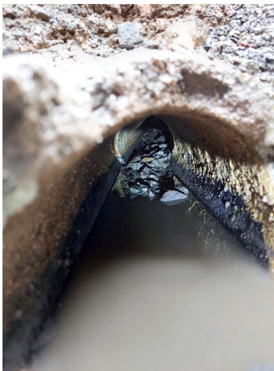
Obr. další fotodokumentace ucpané dešťové části vodovodu
