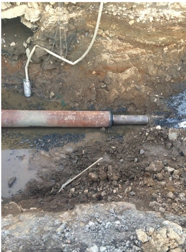
Obr. potrubí mezi šachtou ŠA-11 A ŠA-12, uloženo bez geotextilie a bez drenáže
