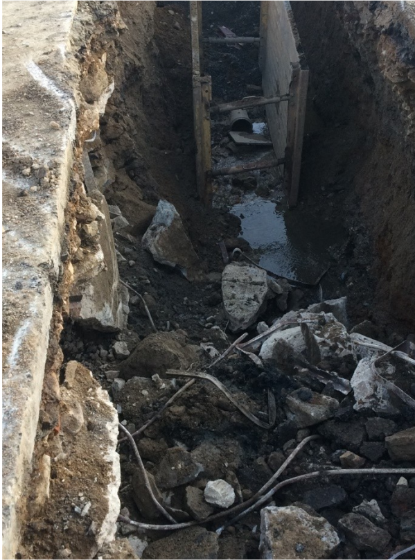
Obr. potrubí mezi šachtou ŠA-11 A ŠA-12
