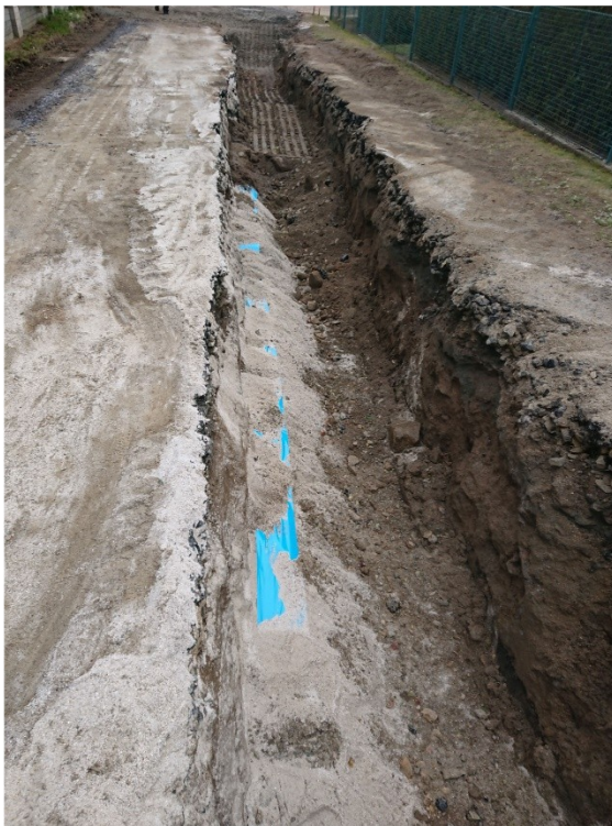
Obr. uložení vodovodního řádu mezi šachtami ŠB1-7 a ŠB 1-8
