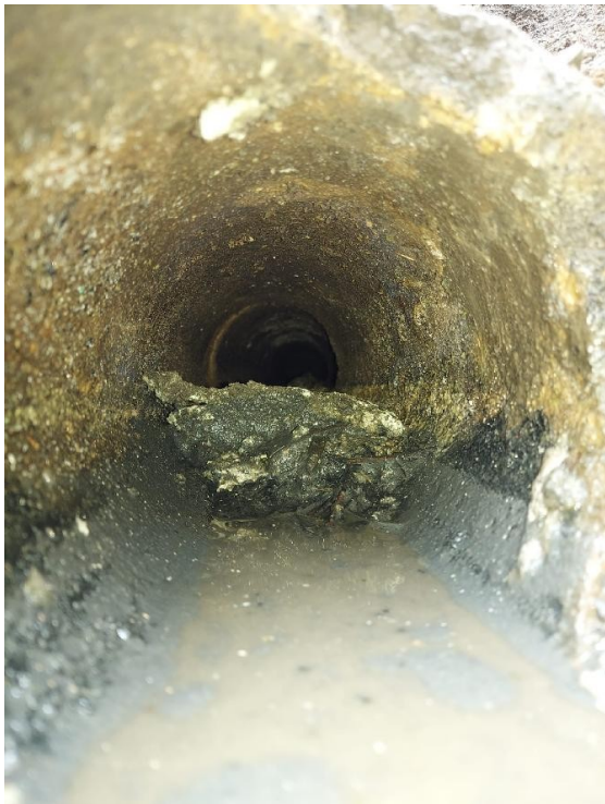
Obr. další fotodokumentace ucpané dešťové části vodovodu
