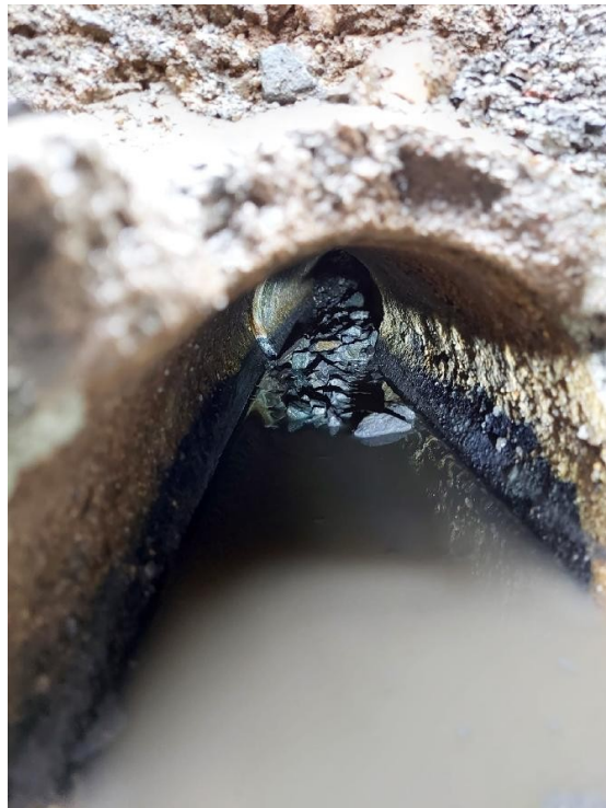
Obr. další fotodokumentace ucpané dešťové části vodovodu
