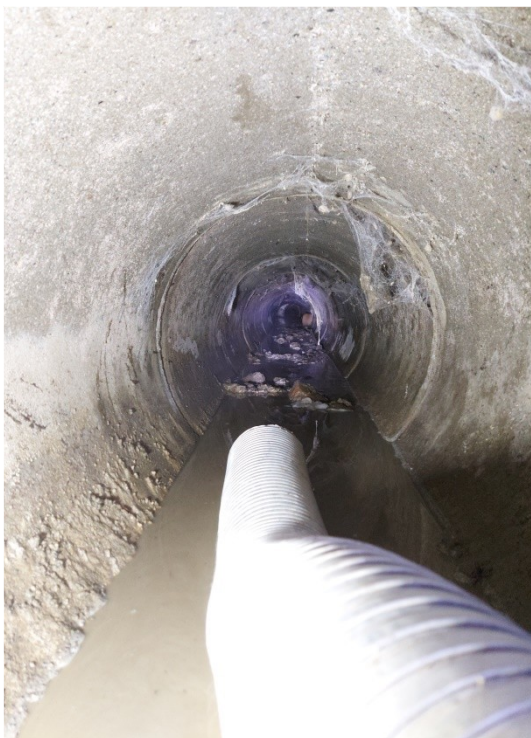
Obr. dešťová kanalizace vedoucí do místního potoka směrem od obce Otín
