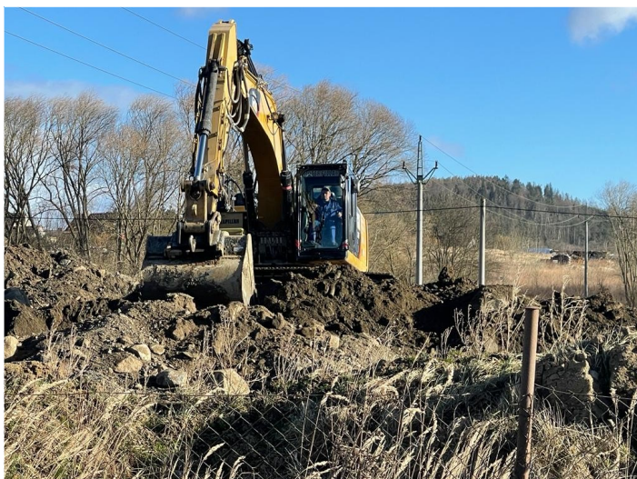
Obr. provádění terénních úprav s odpadem na dotčených pozemcích
